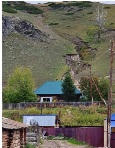
Рис. 9 Дорога Катонкарагай-Рахмановские ключи, пос. Орель. Формирование эрозионного вреза на крутом склоне. Опасное расположение дома и строений у подножья склона на пути потока
