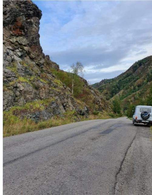
Рис.3 Дорога Усть-Каменогорск-Зыряновск, перевал Осиновый. Крупные выходы коренных пород высотой до 30-35 м. Протяжённость обвалоопасного участка до 300 м
