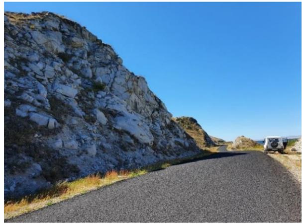
Рис. 7 Дорога Улькен Нарын-Курчум, 49 км. При строительстве дороги, образовались крутые откосы, представляющие большую вероятность возникновения обвальных процессов
