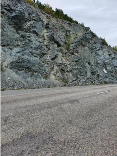
Рис. 2 Дорога Усть-Каменогорск-Зыряновск 27 км. Обвалоопасный участок длиной 270-300 м. Крупные выходы коренных пород разбиты густой сетью трещин.
