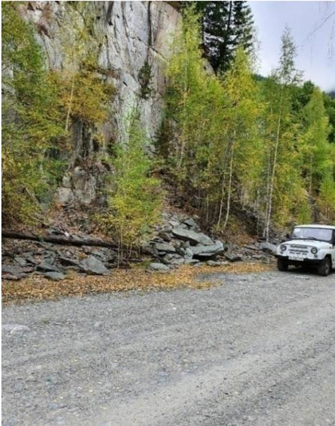
Рис. 4 Восточно-Казахстанская область, дорога Караайрык-Рахмановские ключи, 8 км, обвалоопасный участок, протяжённостью до 300 м, крупные выходы коренных пород, высотой до 15-20 м. Крутые, почти отвесные скалы разбиты густой сетью трещин. Большая вероятность обрушения даже при слабых землетрясениях
